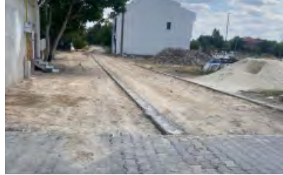
İlçemiz Durak Mahallesi Dönertaş 2. Ara Sokak Yolunun Beton Parke Taş ile Yenilenmesi Yapım İş
