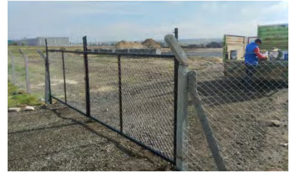
Belediyemize ait İstiklal Mahallesi Hükümet Caddesi ile Manastır Caddesi arasında kalan alanda beton direkli kafes teli ile himaye çiti yapılması işi
