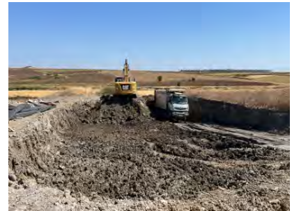
İlçemiz Muhtelif Cadde ve Sokaklarında Yol Açılması Yapım İş (Selanik Caddesi)
