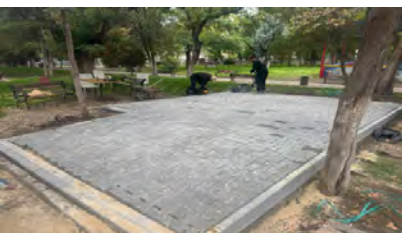
Belediyemize ait Gençlik Parkı içerisinde Kamelya ve Güvenlik Kontrol Alanlarında Parke Taş Düzenlenmesi Yapım İş
