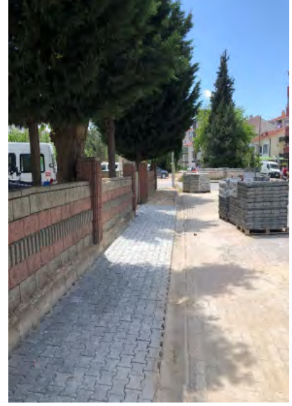
İlçemiz Muhtelif Cadde ve Sokaklarında Kaldırım Yapılması İşi (Donatım Sokak)
