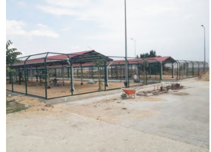
Hayvan Bakım Evi Ek Alan Yapım İş
