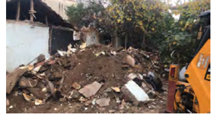
Müdürlüğümüz ekiplerince metruk bina yıkımları yapılmış olup yıkım sonrasında çıkan hafriyat İnşaat Yıkıntı Atığı Tesisimize getirilmektedir.
