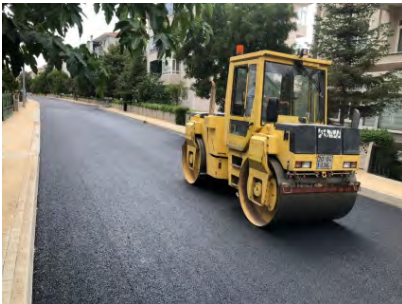
Şehir İçi Yollarda Asfalt ve Sathi Kaplama Yapım İş (Özcan Değirmencioğlu Caddesi)
