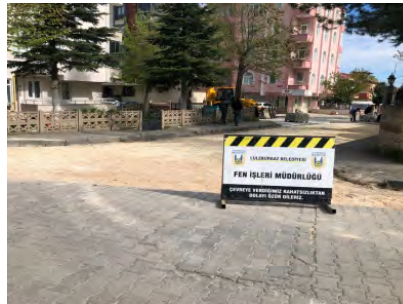
İlçemiz Yollarında Tamirat ve Yol Yapım İş (8 Kasım Caddesi)
